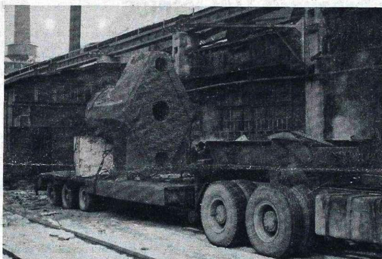
Najtežji, 55-tonski, odlitek doslej, izdelan za tovarno Ivo Lola Ribar. Odpuslan v januarju 1984. (fotoarhiv Železarne)
