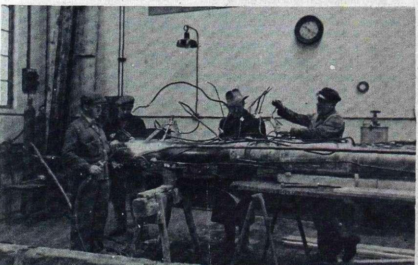
V instalcijski delavnici pri obnovi kolone: Štefan Brelih, strojnik v kisikarni; Alojz Mrak, delovodja; Ivan Bevc in Ivan Mohorič, kleparja. Od vseh je še živ le Ivan Mohorič
