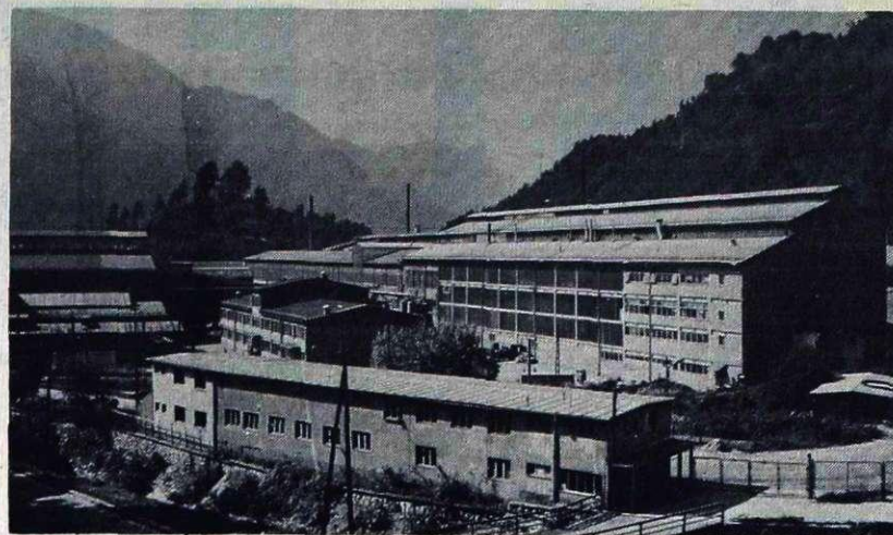
Obrati na Javorniku (foto: M. Kolenik)
