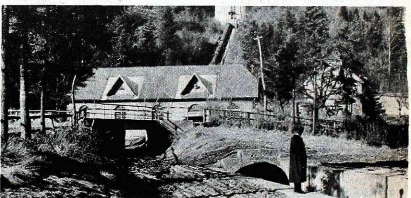
Suha zima ne bo prizanesla elektrarnam. Na sliki hidroelektrarna Zasip (foto: Silvo Kokalj)
