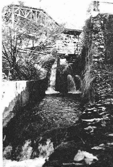
Zahodni del zidovja fužin na Stari Savi (foto: S. Kokalj)
