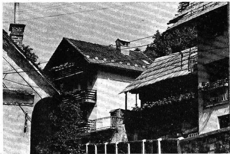
Murova (foto I. Kučina)
