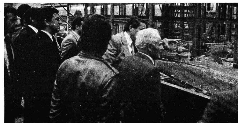
Udeleženci pogovora so si ogledali gradbišče Jeklarne 2 (foto S. Kokalj)
