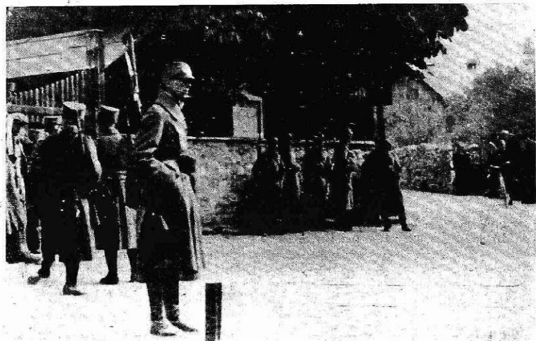
Stavka gradbincev 1936. na Javorniku
