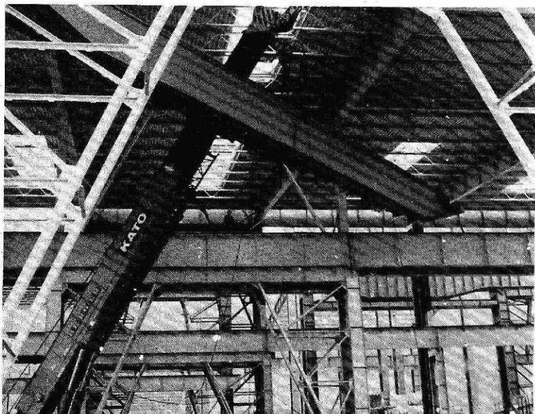
Jeklarna 2, montaža žerjava (foto I. Kučina)
