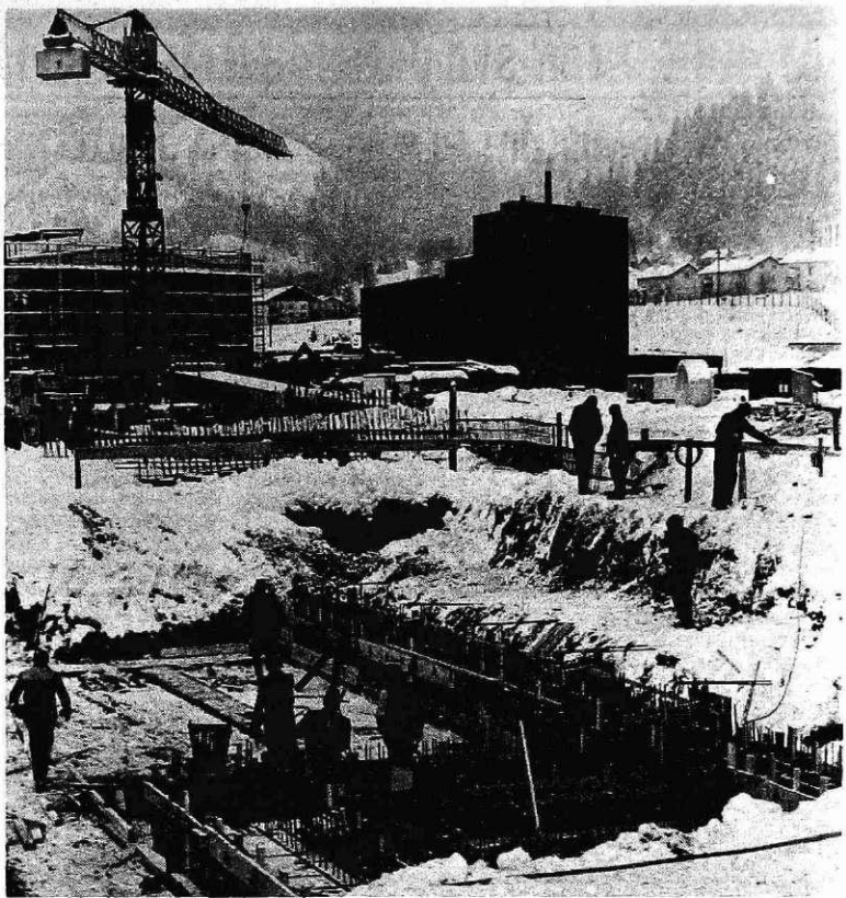
Jeklarna 2 — temelji za trafo postajo 1/4—7. 2. 1986 (foto I. Kučina)
