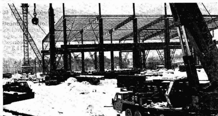
Gradnja Jeklarne 2 (foto I. Kučina)
