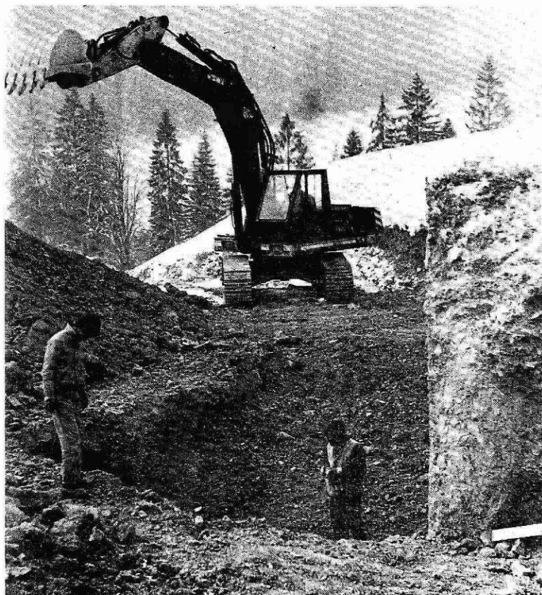
Karavanški predor — gradnja — 7. 2. 86 (foto I. Kučina)
