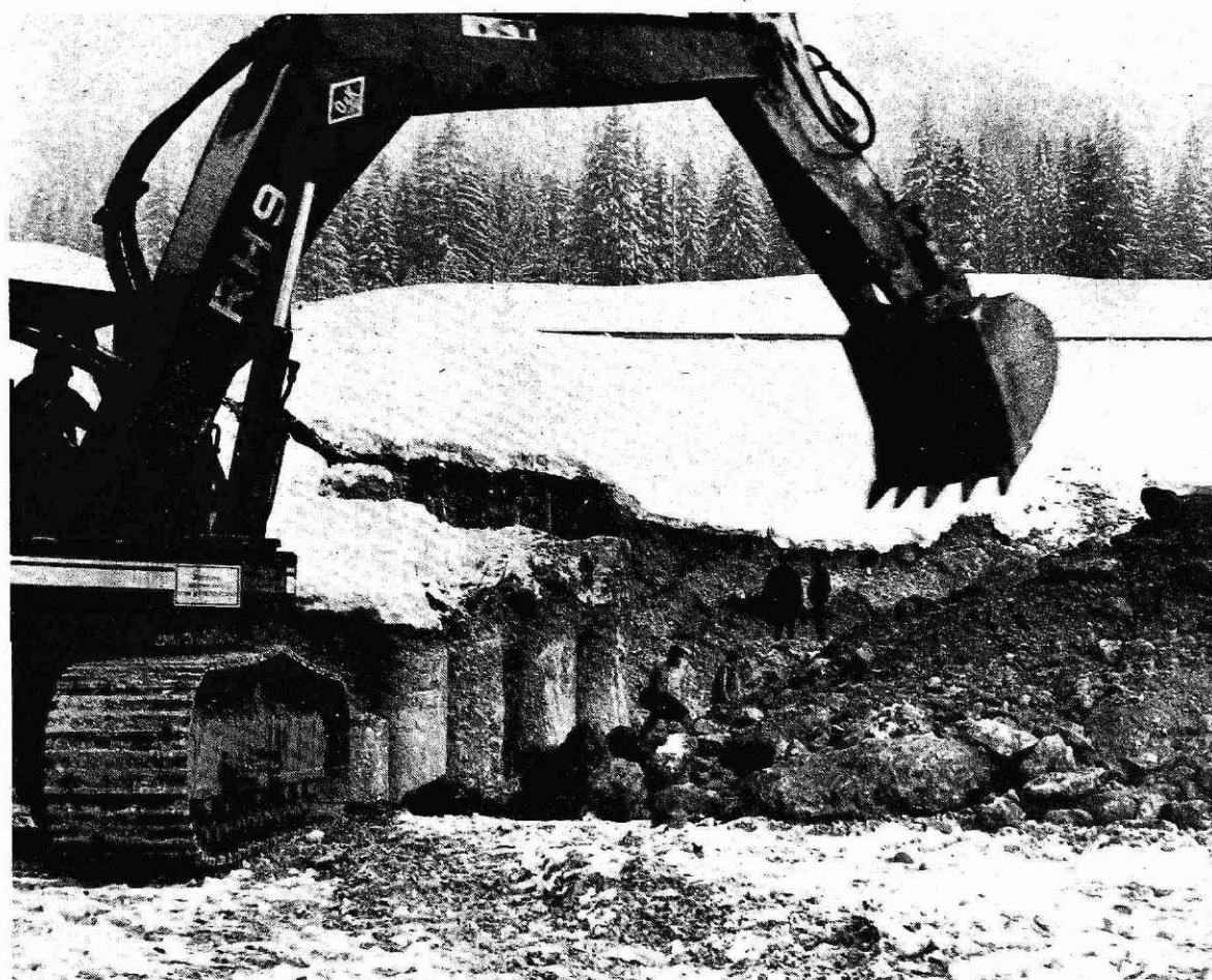
Pričetek gradnje Karavanške predora (foto I. Kučina)
