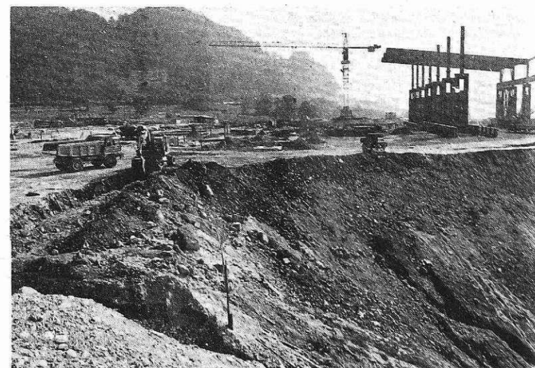
Na gradbišču (foto: I. Kučina)
