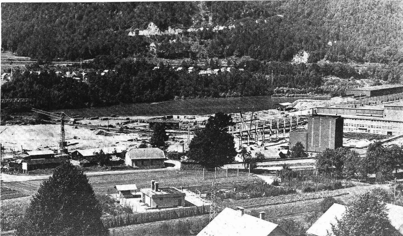
Gradnja Jeklarna 2 (Foto: I. Kučina)
