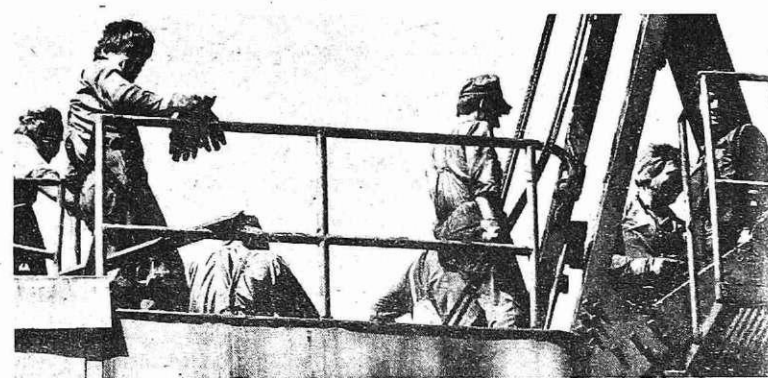
Popravilo žerjava (foto B. Grce)
