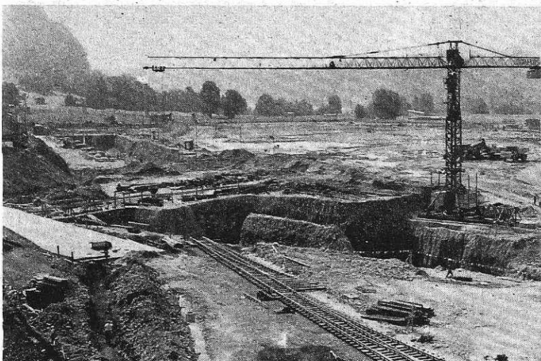
Gradnja Jeklarnе 2 (Foto: I. Kučina)
