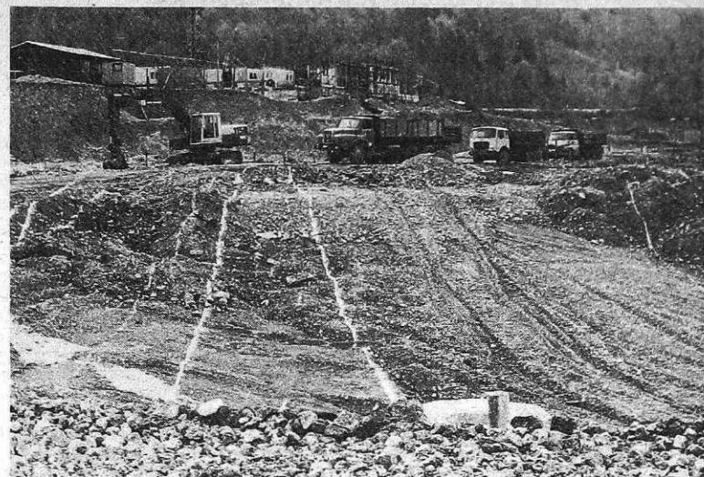
Gradnja Jeklarne 2 (foto I. Kučina)
