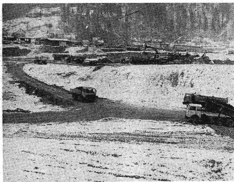
Gradbišče jeklarne 2 15. februarja (foto I. Kučina)
