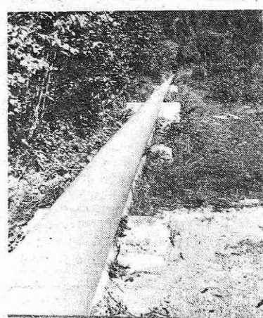
Te dni so delavci montažnega oddelka preklaplili in dali v obratovanje 359 m obnovljenega visokotlačnega cevovoda v Javorniških rovtih. Ta cevovod bo kasneje služil za dovod vode k HE Javornik.
