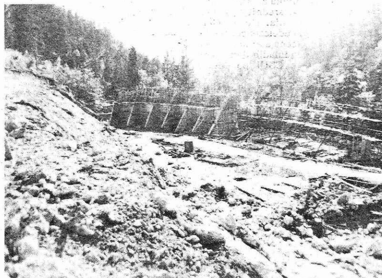
Gradbišče HE Javornik — gradnja bazena za hladilno vodo.
