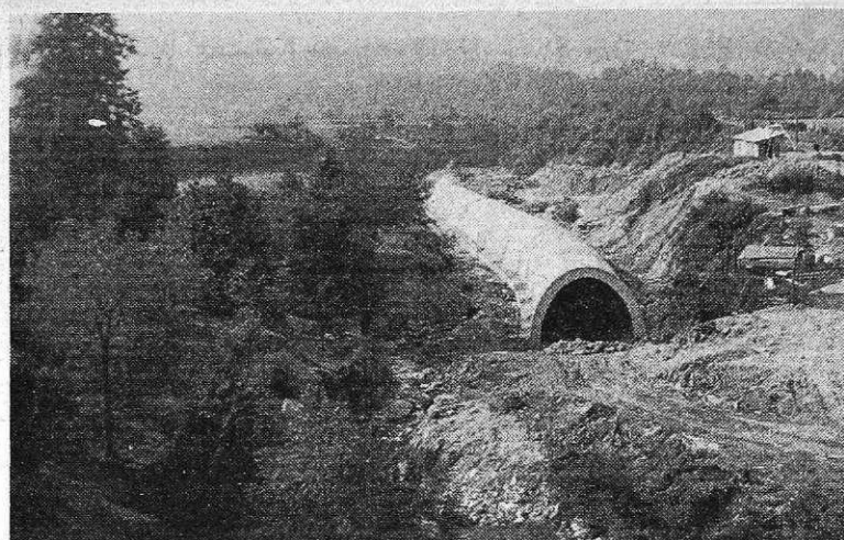
Regulacija potoka Bela sodi tudi med priprave za gradnjo jeklarne 2 (foto I. Kučina)
