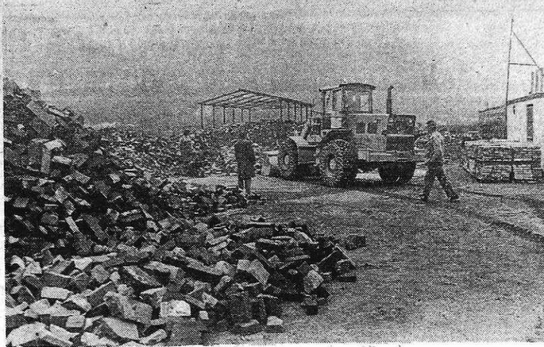
Čiščenje in sortiranje ognjevdžne opeke na nasipu valjarn na Beli za na- daljnjo uporabo (foto I. Kučina)
