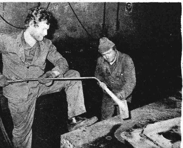
Ravnarje nosilca za kavelj v žerjavnem oddelku (foto S. Kokalj)
