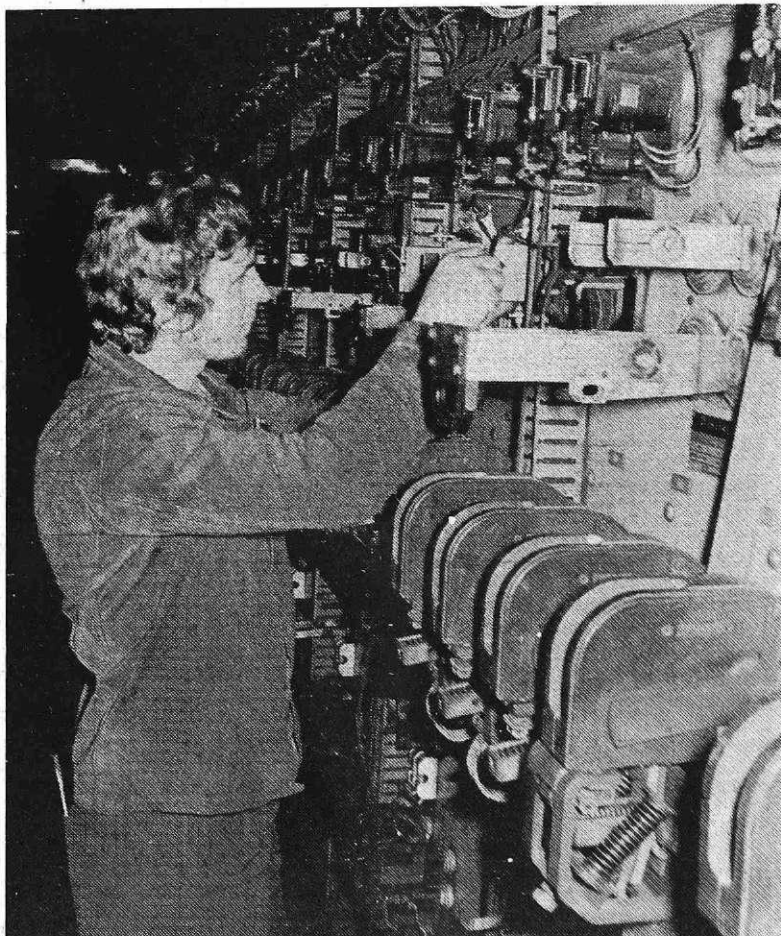
Sodelavec-elektrikar v strojnici valjarne bluming (foto S. Kokalj)
