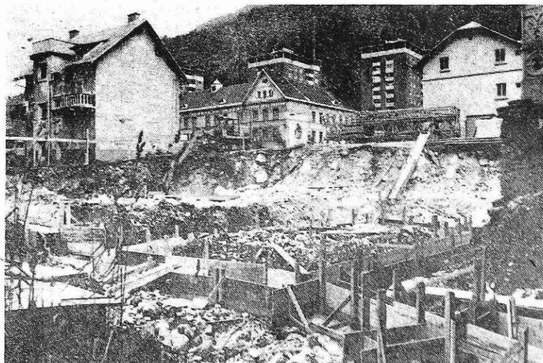
Gradnja večnamenske dvorane na Jesenicah (foto I. Kučina)
