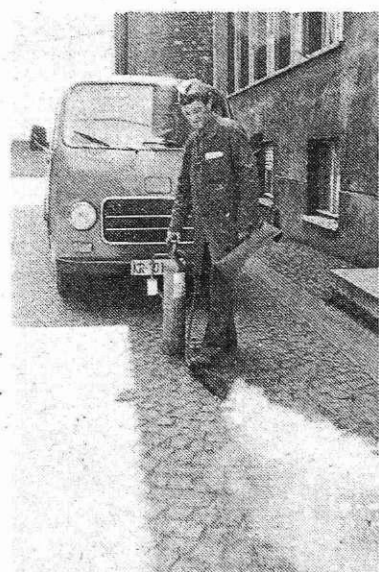
Vsakih pet let je treba gasilni aparat sprazniti in ga tlačno preizkusiti z vodo (foto S. Kokalj)
