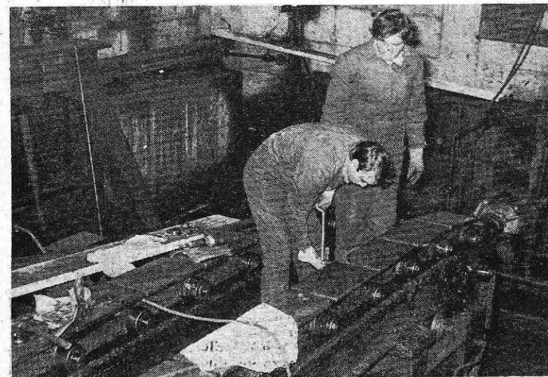
Popraviš transportnega traku za vroče valjano pločevino v valjarni štekel (foto S. Kokalj)
