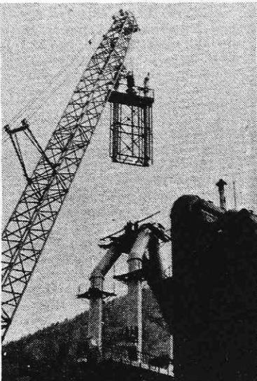
Montaža izpuštnih sveč, najvišjega dela plavža, pri zadnjem remontu (foto Janez Vehar)
