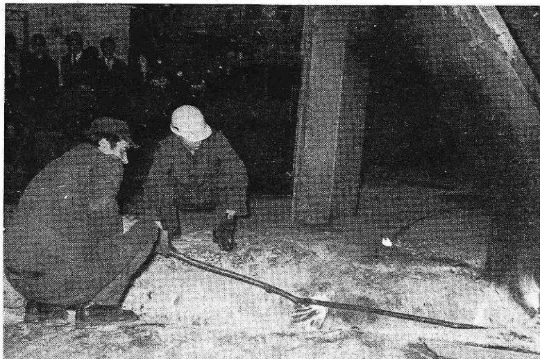
Med prižiganjem prenovljenega plavža 2 (foto I. Kučina)
