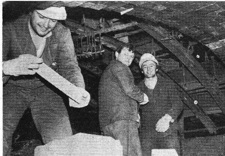
Remont SM peči 04 (foto I. Kučina)
