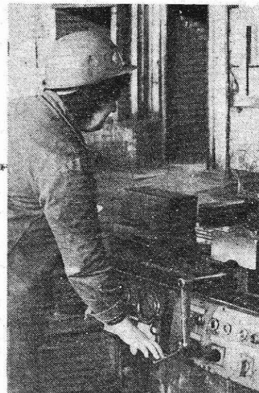
Sodelavka pri krožni žagi za razrez poskusnih vzorcev v valjarni žice in profilov (foto I. Kučina)
