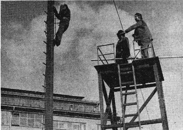
Vzdrževalci ERD pri zamenjavi drsnega voda v valjarni Javornik (foto I. Kučina)
