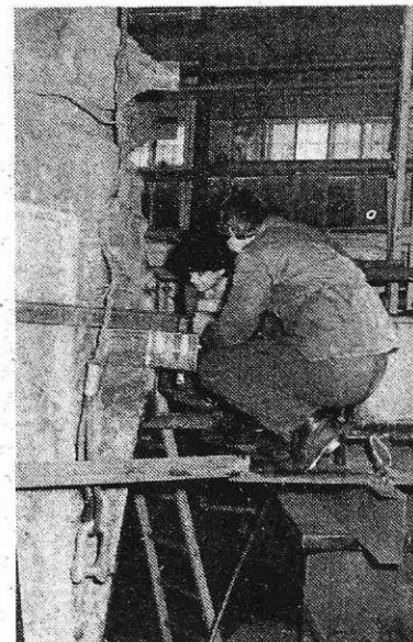
Popravilo ponve v obratu konstrukcij TOZD Strojne delavnice (foto S. Kokalj)
