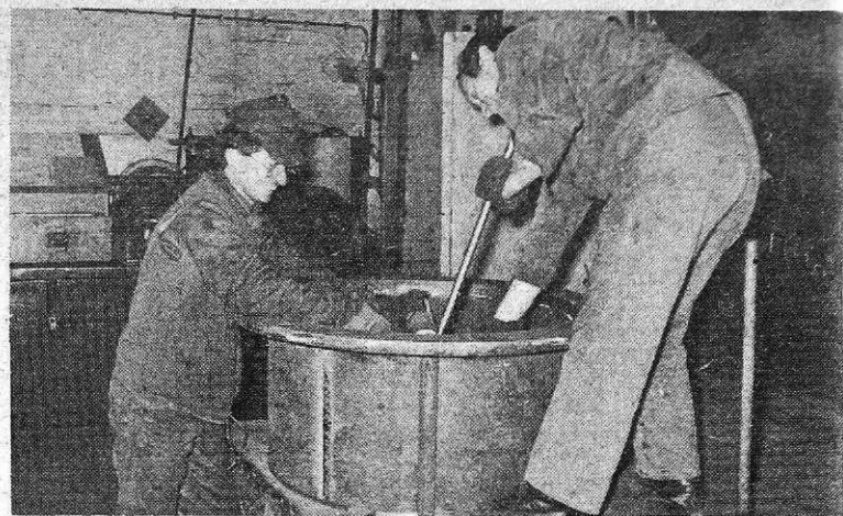
Izdelava šobe za vpihavanje za plavž 2 v obratu konstrukcij TOZD Strojne delavnice (priprava na remont plavža 2) (foto S. Kokalj)
