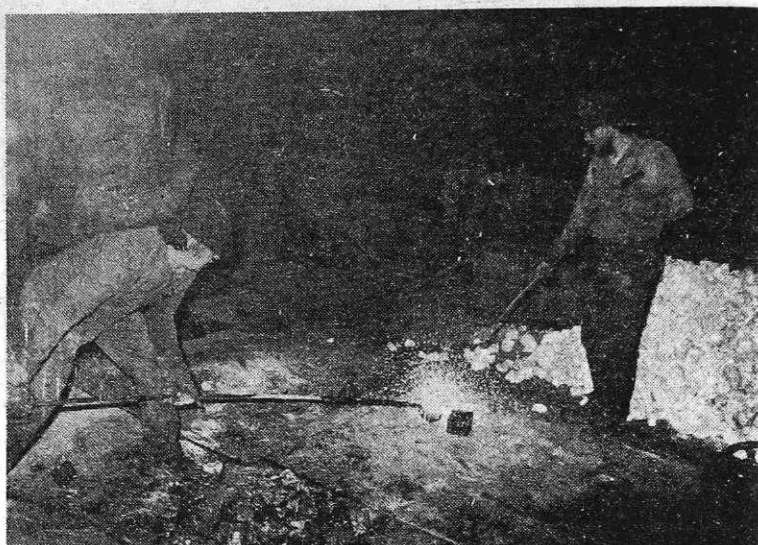
Jemanje vzorca surovega jekla (foto S. Kokalj)
