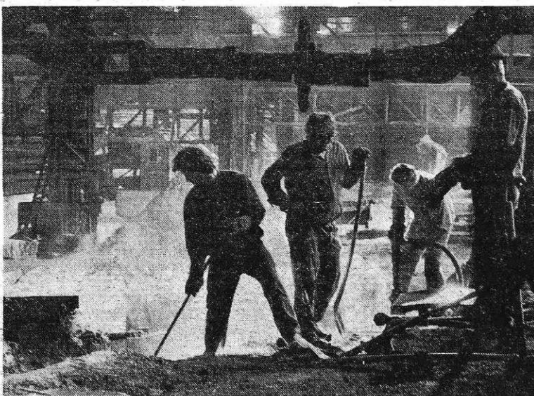
Priprava livnega žleba pri plavžu (foto I. Kučina)
