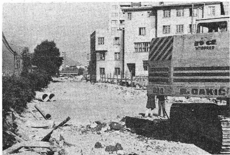
Gradnja obvoznice na Jesenice (foto I. Kučina)
