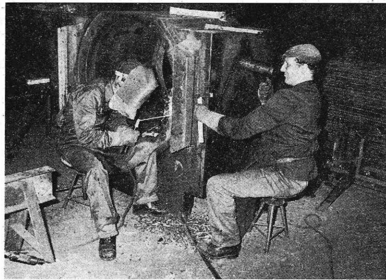
Popravilo valjavnikega ogrodja valjarne bluming v konstrukcijski delavnici (foto S. Kokalj)
