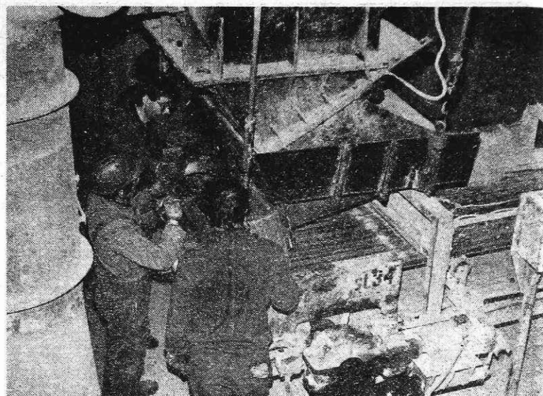
Vzdrževalci pri popravilu drobilca v aglomeraciji (foto I. Kučina)
