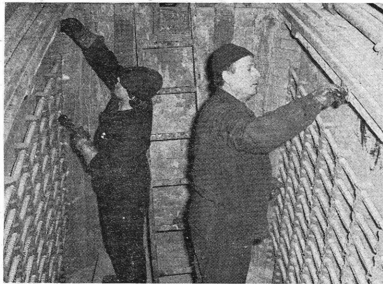
Remont na sušilnih pečeh v hladni valjarni Jesenice (Foto S. Kokalj)
