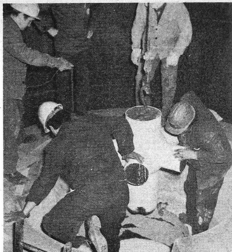
Formiranje glave gorilnika za hidroelektrarno Mavčiče (foto S. Kokač)
