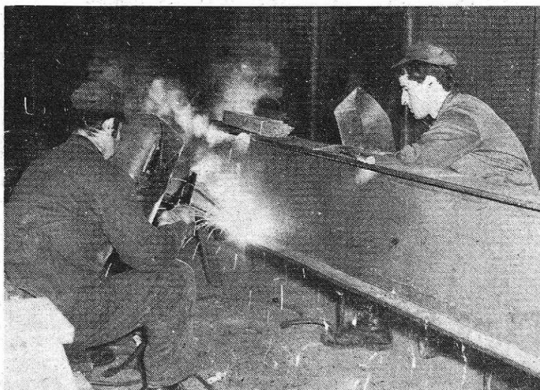
Sodelavca varilec v konstrukcijski delavnici (Foto S. Kokalj)
