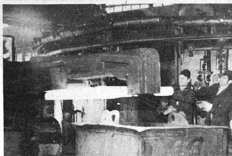
Odstranjevanje zaščitne pločevine v valjarni debele pločevine (Foto I. Kučina)
