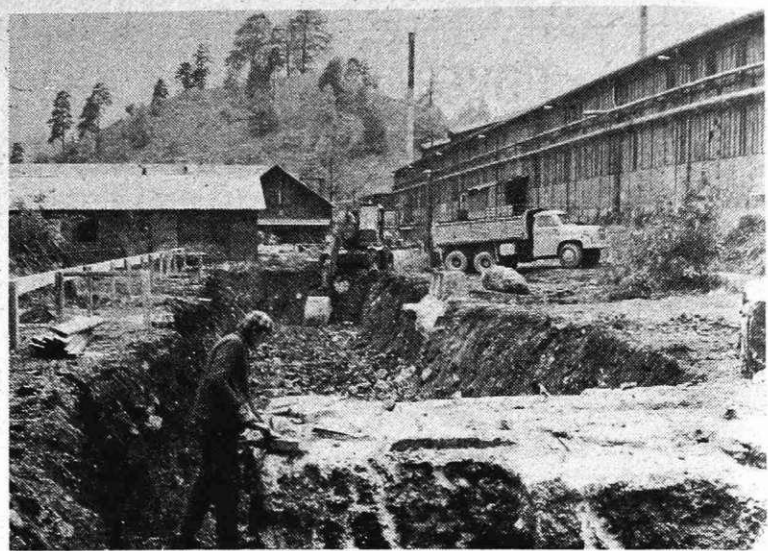
Zemeljska dela za novo halo odpreme valjarne debele pločevine (Foto I. Kučina)
