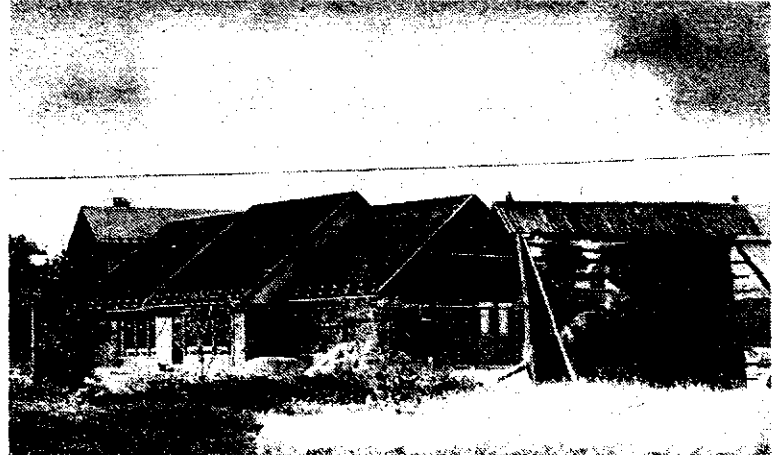
Gradnja vrtca poleg osnovne šole 16. december v Mojstrani (Foto I. Kučma)
