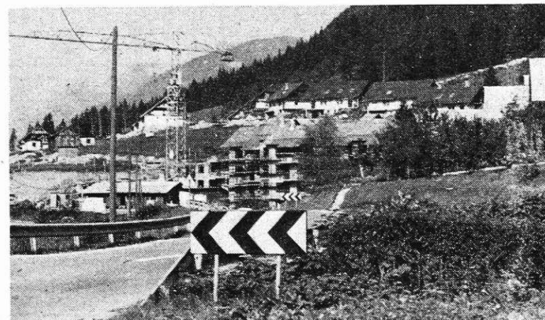
Gradnja blokov in družbenih stanovanj v okviru stanovanjske zadrage Železar na Hrušici (Foto I. Kučina)
