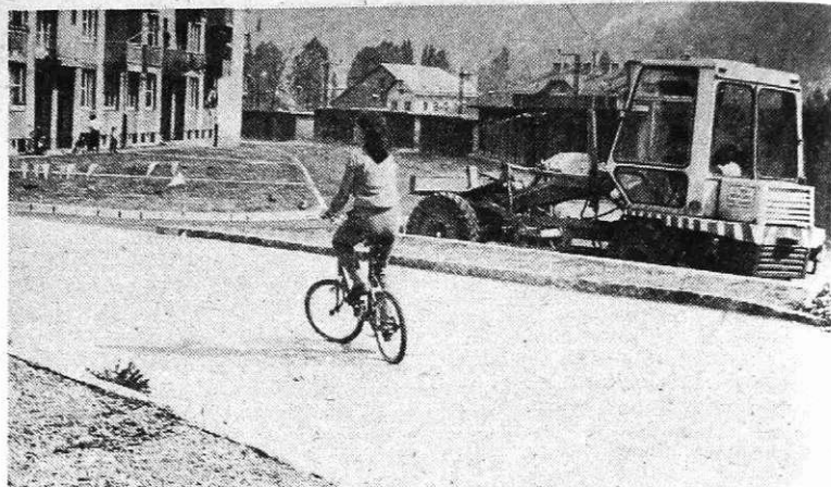
Okoli stanovanjskih blokov na Plavžu je potrebno še precej površin ustrezno urediti. Letos so na vrsti površine ob blokkih na Cesti revolucije števil. 5 do 9. Delavci komunalnega podjetja Kovinar so južno od blokov asfaltirali pot za vozila in uredili zelenico kot predvidena ureditveni načrt. (Tekst in foto B. Blenkuš)
