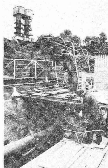
Izkopavanje za črpalke in strojnico za Dorrove čistilce v kisikarni Sava (Foto S. Kokalj)
