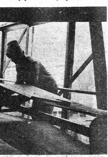
Montaža novega traku na aglomeraciji (Foto I. Kučina)
