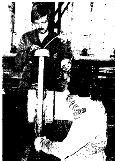
Elektrikarja pri popravilu žerjava (Foto S. Kokalj)
