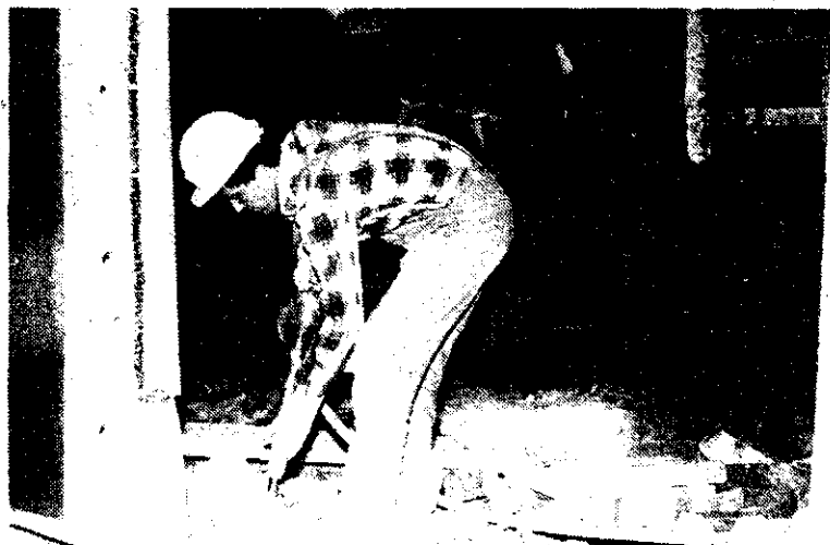
Remont na SM peči (Foto S. Kokali)
