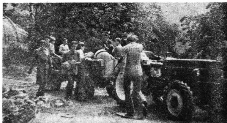
Krajani Javorniškega rova so pričeli z izgradnjo lastnega gasilskega doma. Posnetek kaže nedeljsko delovno akcijo pri betoniranju temeljev. V akciji, ki so se je zelo resno lotili, so sodelovali predvsem mladi graničarji s karavle, graditelji počitniških hišic in ostali vaščani, med njimi tudi starejši. (Tekst in foto Zdravko Noč)
