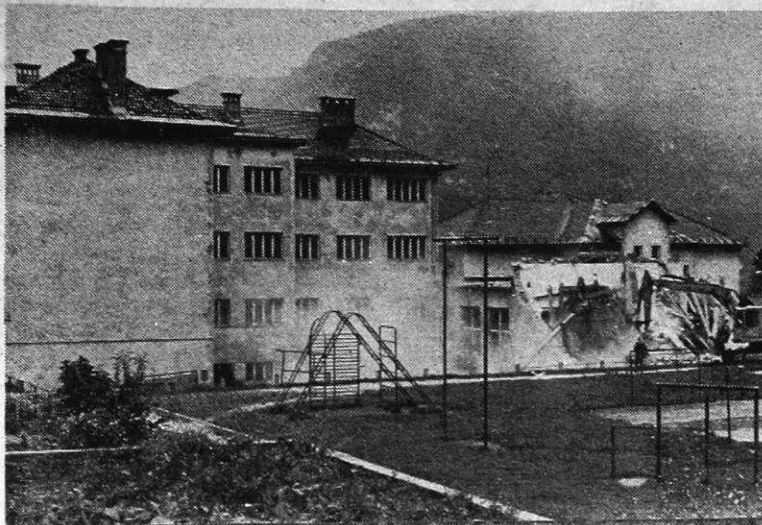
Rušenje dela osnovne šole Karavanjskih kurirjev NOB na Koroški Beli (Foto I. Kučina)
