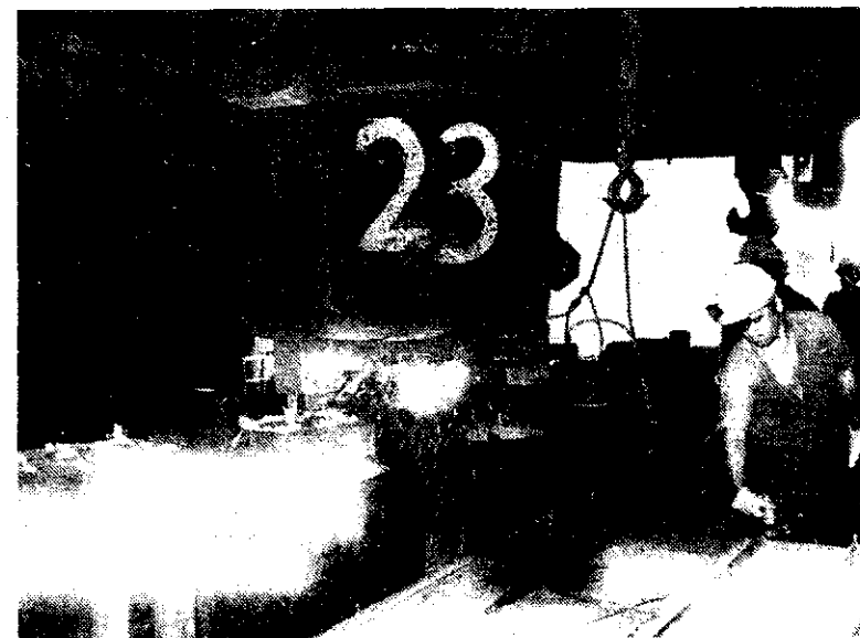
Vlivanje jekla v kokile (Foto I. Kučina)
