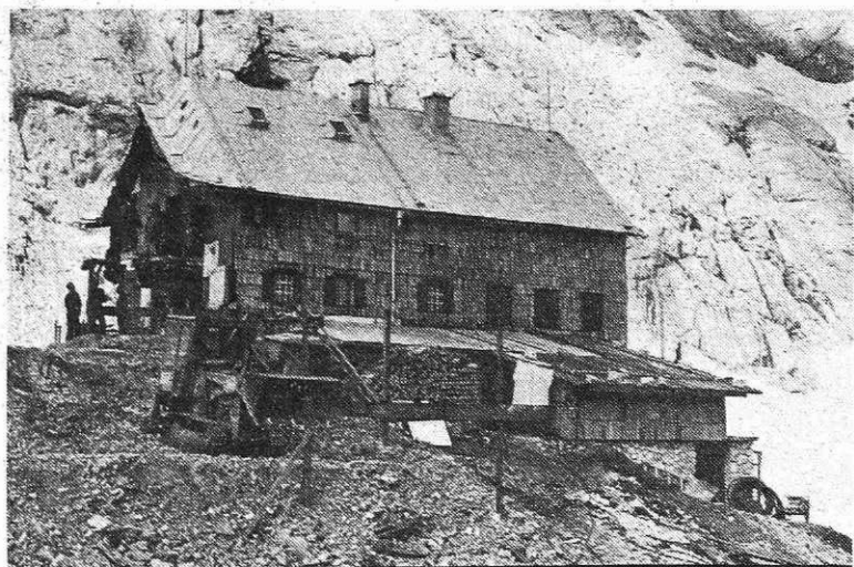
Gradbišče na Kredarici prejšnji teden (Foto J. Rabič)
