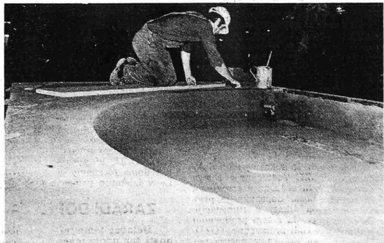
Livar pri izdelavi kalupa za odlitek zobatega kolesa (Foto I. Kučina)
