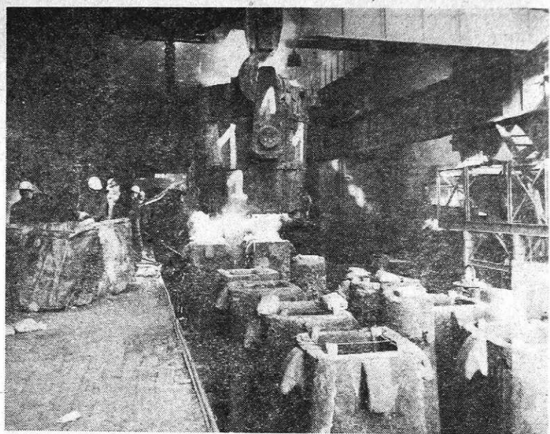
Vliivanje jekla (Foto I. Kučina)
